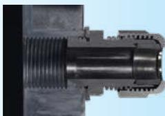
Mit üblicher M20-Kabelverschraubung
